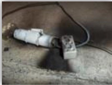
Celda sometida a alta temperatura
